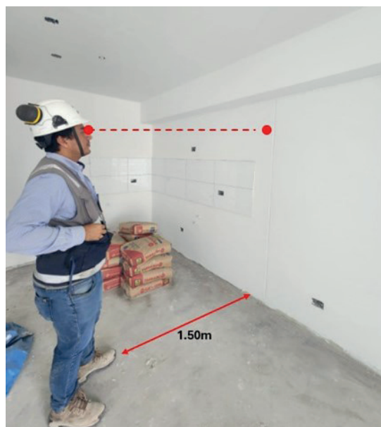
Fig. N° 26: Verificación de pintura interior
