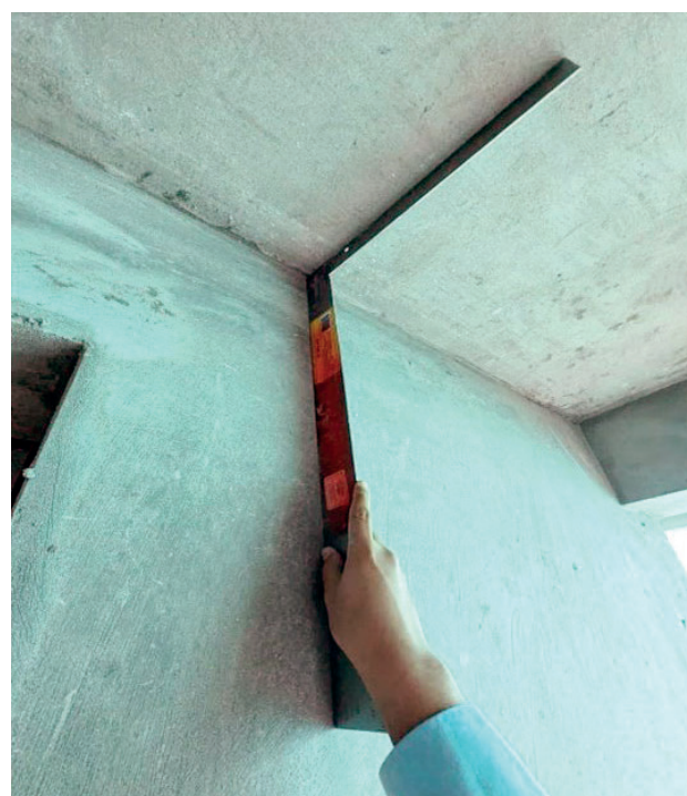
Fig. N° 6: Cuadratura del muro de concreto con otros elementos
