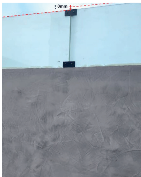
Fig. N° 37: Alineación de vidrios
