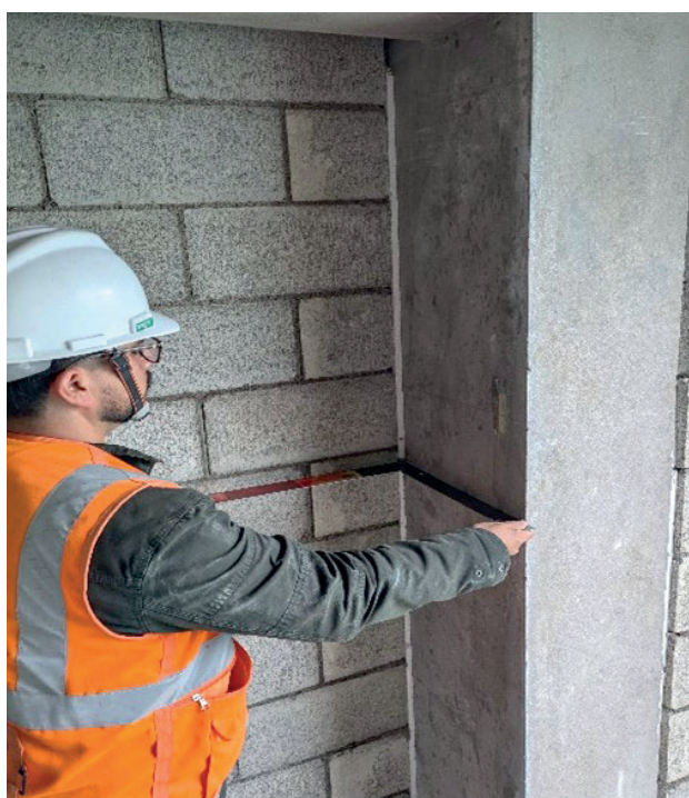
Fig. N° 6: Cuadratura del muro de concreto con otros elementos
