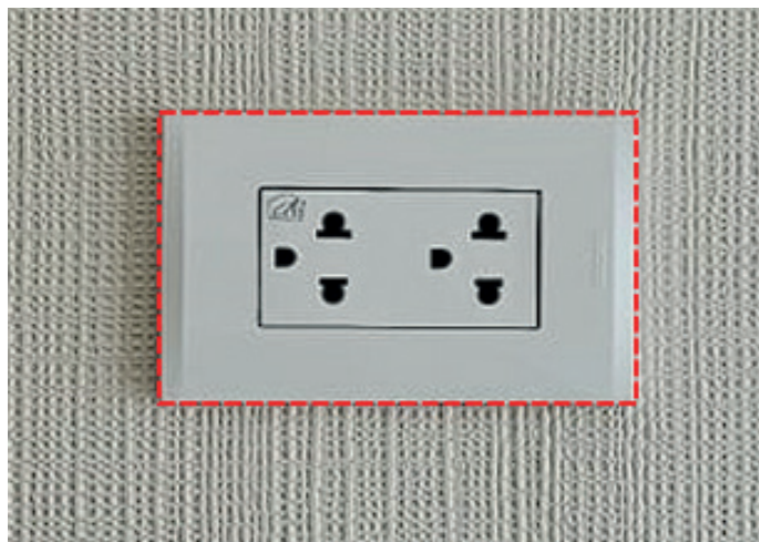
Fig. N° 70: Horizontalidad del accesorio
