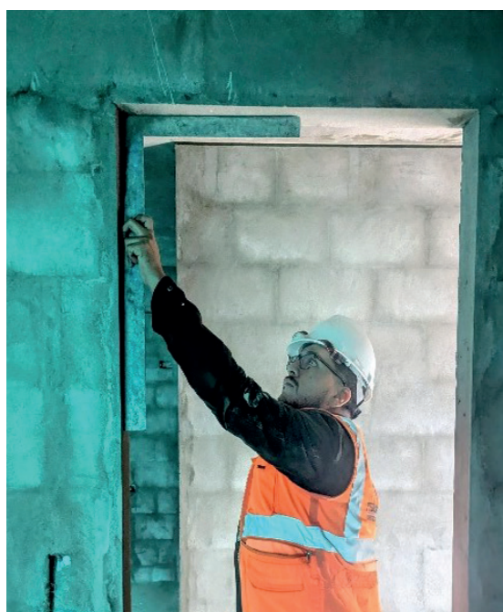
Fig. N° 17: Cuadratura de esquinas
