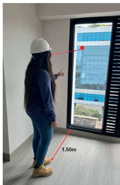
Fig. N° 38: Verificación de manchas, rayas, abolladuras / decoloraciones y acabado del sellado
