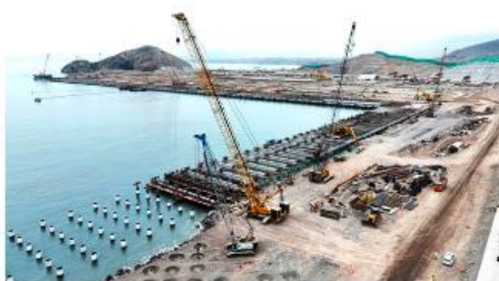
La primera etapa del Megapuerto de Chancay, que deberá ser culminada en noviembre próximo para la cumbre APEC 2024, ocupa una inversión netamente privada de US$1.300 millones. Foto: difusión
