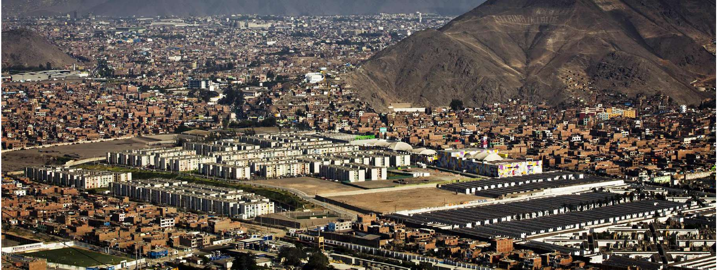
Proyecto Los Parques del Agustino sobre antiguo cuartel La Pólvara
