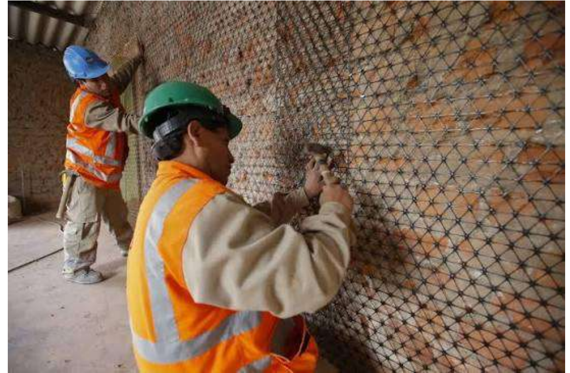
Intervención de reforzamiento estructural Foto: Agencia Andina
